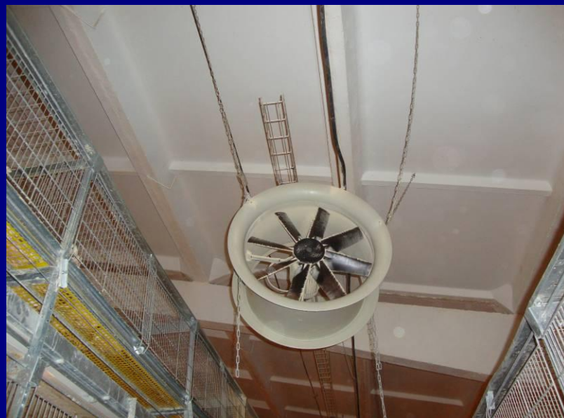
循环风机：30m一个，每列3个，共6个。悬挂时有10°的倾斜角度，风量1-1.1万m 3 /h。
