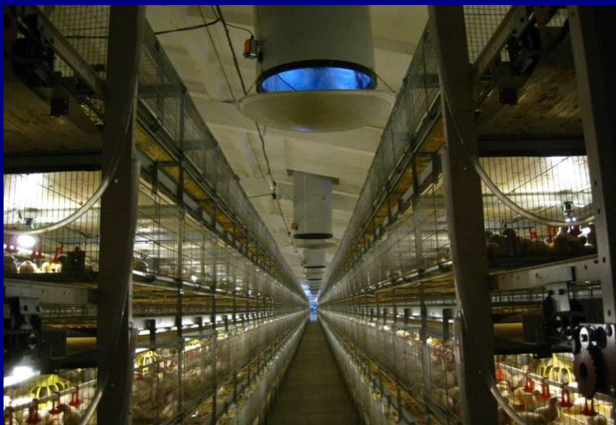
屋顶风机，16个，排量20000m 3 /h
