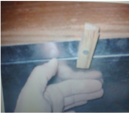
关闭的小窗 小窗数目和风机个数相匹配，在育雏期和冬季，一定数量的小窗必须关闭以确保好的空气流动
